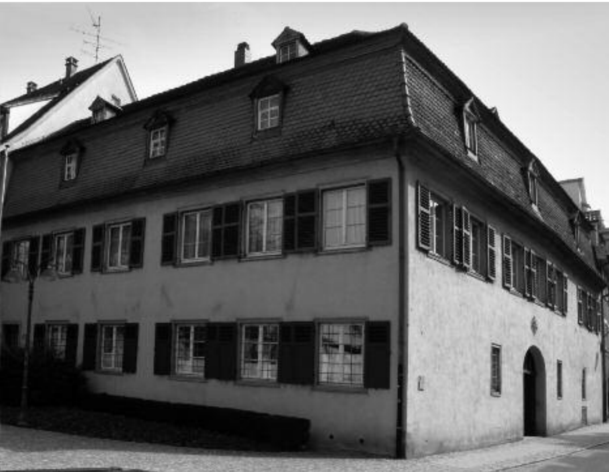
Pfarrhaus Liebfrauen vor der Sanierung, 2009
