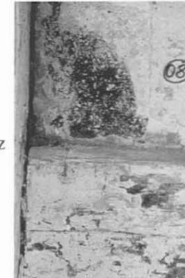
Schicht I: Gebälk grau, Gefache ausgemauert, mit feinkörnigem Kalkputz bündig mit dem Holzwerk verputzt und hellem Kalkanstrich versehen. Dunkler breiter Begleitstrich in den Ecken mit Kreissegmenten abgefasst.
