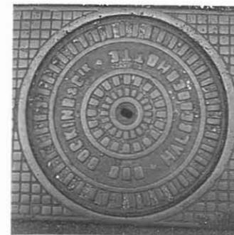
genden Beispiele aus verschiedenen Gießereien belegen. Zum Teil wurden sie aus Kostengründen jedoch zunehmend mit Beton ausgegossen (Begu = Betonguss) und in der Altstadt aus gestalterischen Gründen mit Pflastereinlagen versehen. Hatten die Hydrantendeckel früher einen Durchmesser von 50 cm, mussten sie in
