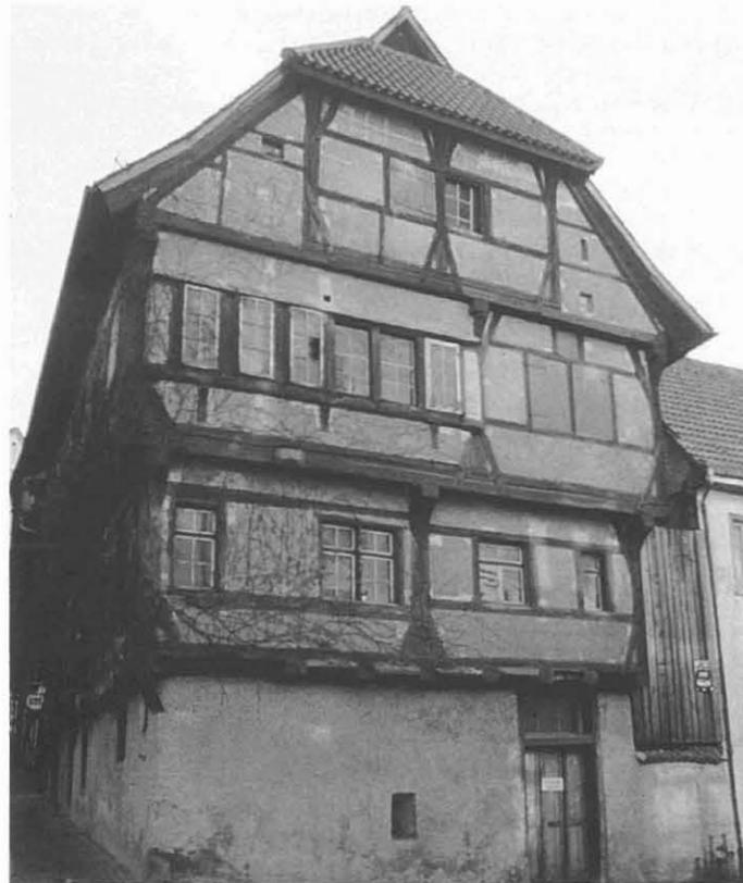
Auf aus Feldsteinen gemauertem Sockel wurde das Haus in alemannischem Fachwerk mit Krüppelwalmdach aufgebaut. Zur fällig gewordenen Dachsanierung mussten die Fassaden 1985 eingerüstet werden. Bei der Gelegenheit konnten von meinem Atelier am Äußeren und Inneren des Hauses partielle Befunduntersuchungen ausgeführt und dokumentiert werden. Deren Ergebnisse werden im Folgenden kurz dargestellt und erläutert.
