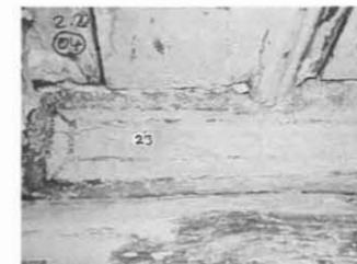
Im 2. OG Süd-Ost-Ecke befindet sich eine Holzbalkendecke mit geschnitztem und bemaltem Fries, vermutlich Schicht II.
