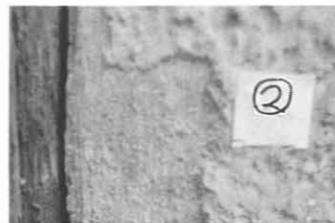
Schicht IV: Vermutlich grober Kalkzementputz mit stark verschmutztem Anstrich.
